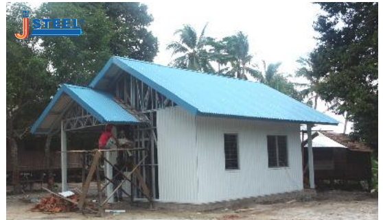
Rumah Prefab Kepi - Papua
