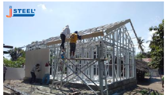
Rehabilitasi Gempa Lombok
