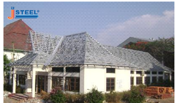
Gedung Koni - Cirebon
